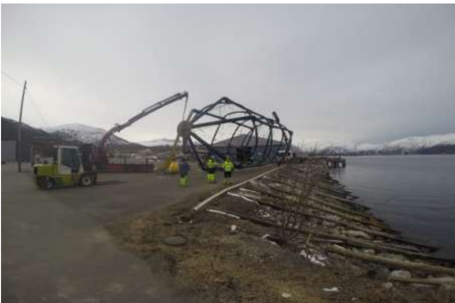
Bilde 1. Sjøsetting av første prototyp SuperTankMerd
